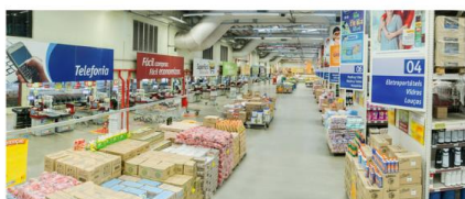
SUPERFÁCIL ATACAREJO - João Pessoa, PB Capacidade Instalada de 450 TR - Splitão VRF Sigma Hitachi, rede de dutos octagonais em MPU e automação
