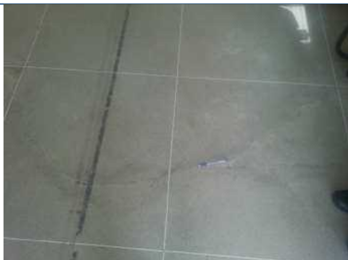
Foto 49 – Fissura no piso da recepção.
