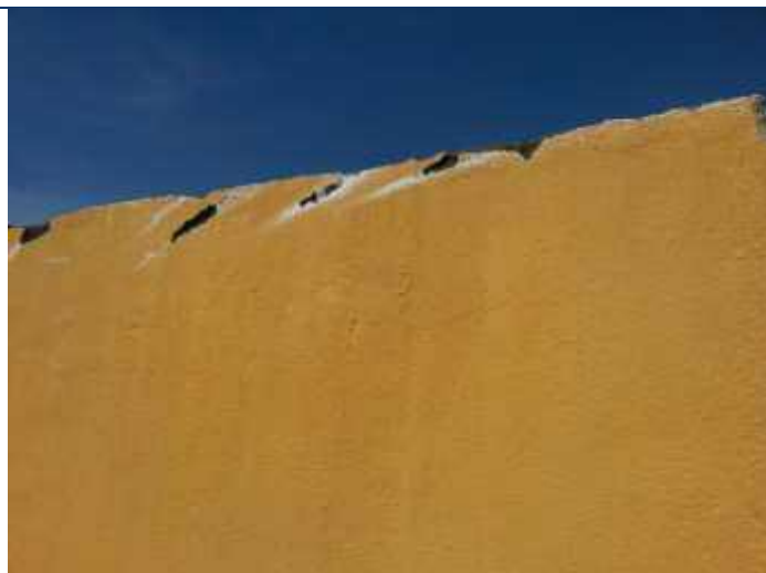
Foto 39 – Platibanda danificada na fachada lateral esquerda.
