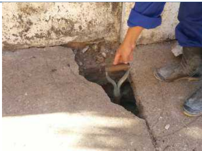
Foto 42 – Detalhe da profundidade do buraco formado abaixo das placas de concreto.
