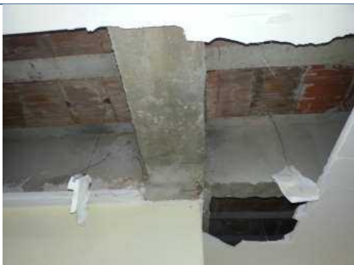
Foto 55 – Quebra do forro de gesso para inspeção.
