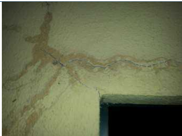
Foto 60 – Diversas fissuras encontradas acima do canto da porta.
