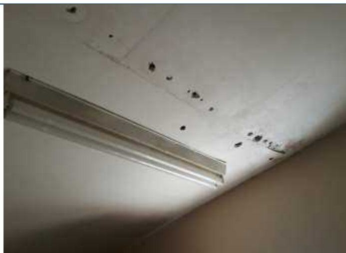
Foto 88 – Infiltração devido a vazamento na calha .
