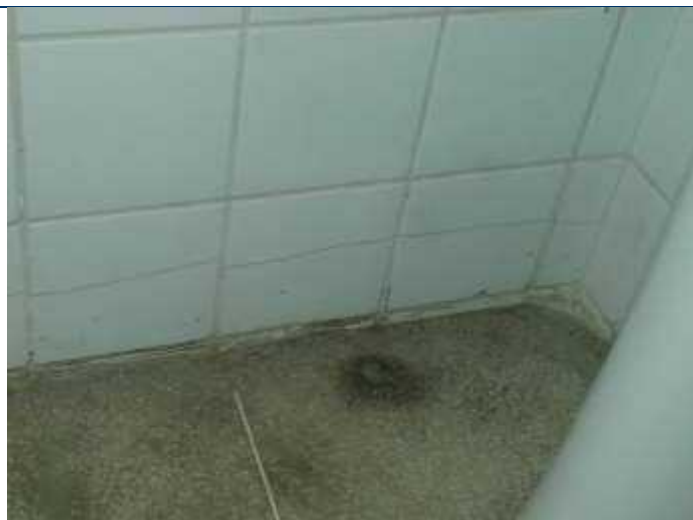
Foto 92 – Piso em granilite danificado e cerâmica com fissura horizontal.
