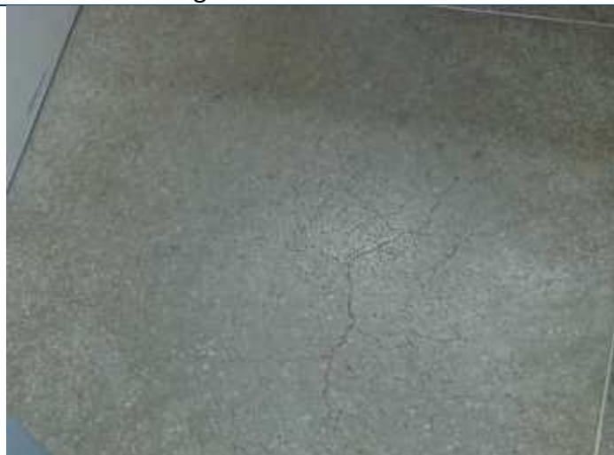
Foto 76 – Fissuras no piso.
