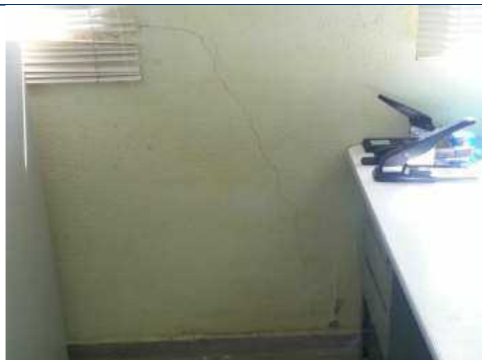
Foto 81 – Detalhe da fissura inclinada.
