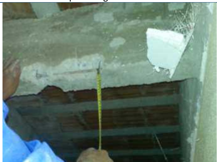
Foto 114 – Medição do cobrimento da ferragem.
