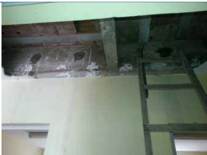
Foto 115 – Detalhe do fechamento dos furos onde foram extraídos os testemunhos de concreto.
