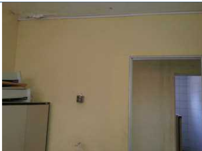
Foto 94 – Forro de gesso danificado por vazamento de água de chuva pela calha.
