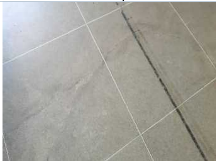
Foto 75 – Fissuras no piso.
