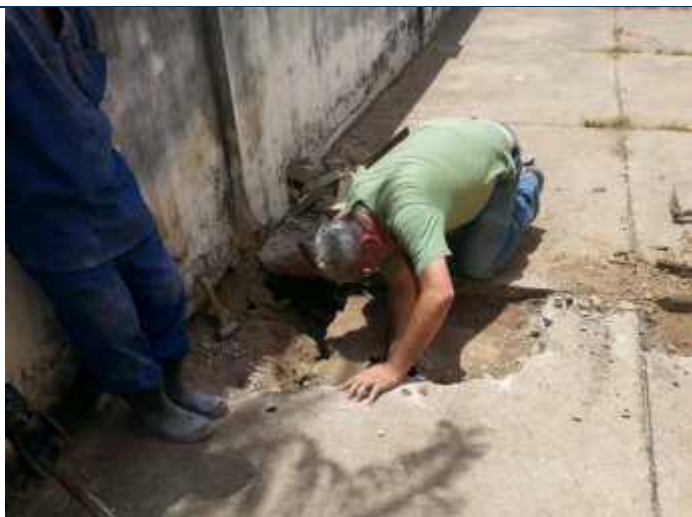
Foto 117 – Inspeção para identificação do sistema de esgotamento sanitário e visualização do aterro.
