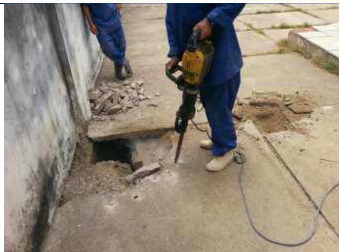
Foto 116 – Quebra do pavimento em concreto para inspeção do aterro e a fossa negra.
