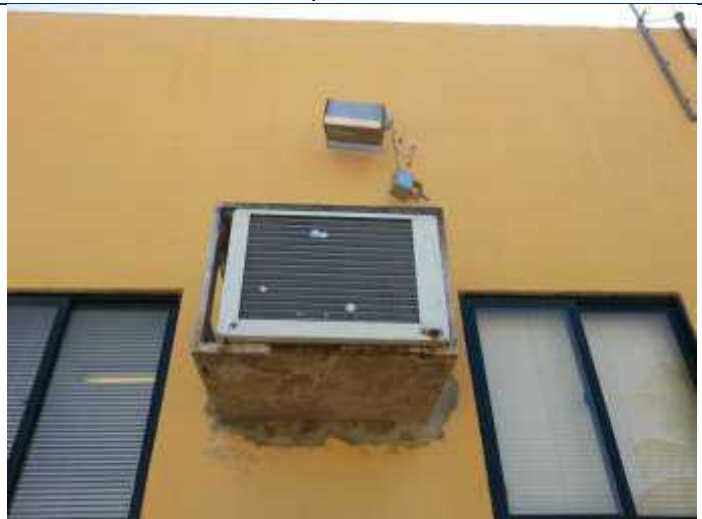
Foto 23 – Falta de grades nas janelas e caixa pré-moldada de concreto do aparelho de refrigeração de ar danificada.
