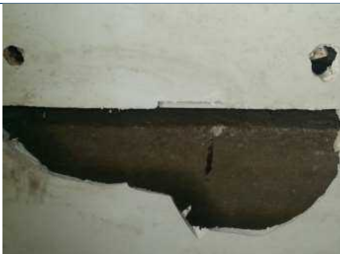
Foto 103 – Quebra do forro de gesso na sala de depósito.
