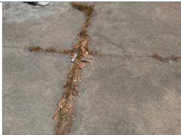
Foto 43 – Local de acúmulo de água pluvial entre as placas de concreto.
