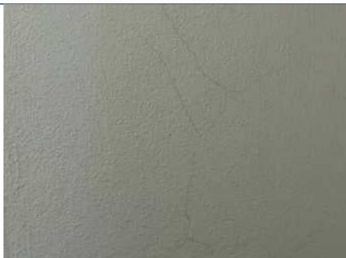
Foto 68 – Diversas fissuras encontradas na alvenaria.
