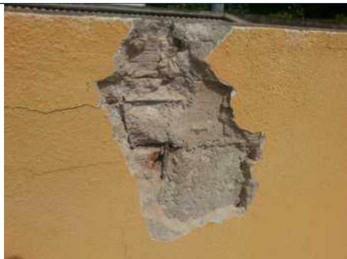
Foto 124 – Escarificação para identificação do concreto armado na platibanda.
