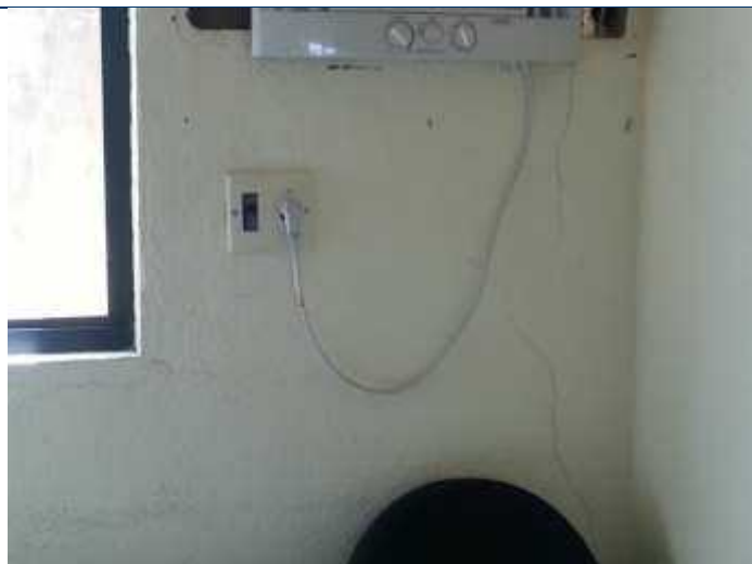
Foto 89 – Parede com fissura vertical abaixo da caixa pré-moldada do aparelho de ar condicionado.
