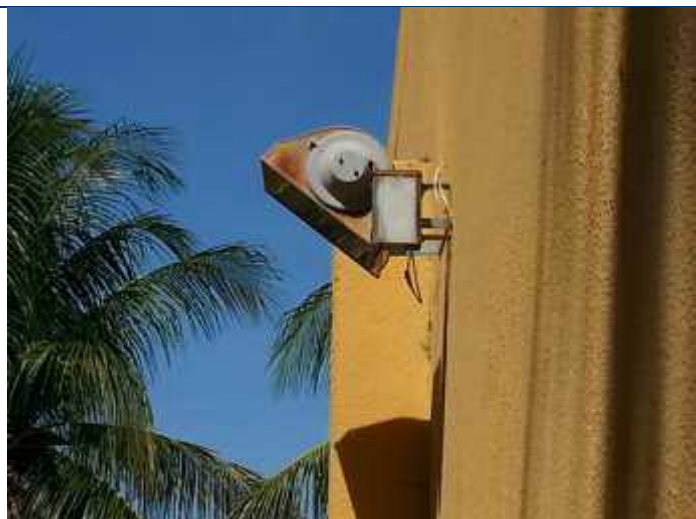
Foto 34 – Refletor com oxidação.
