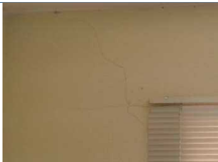
Foto 73 – Fissura de canto na janela.
