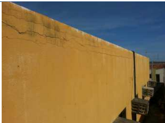
Foto 38 – Fissuras na fachada lateral esquerda.
