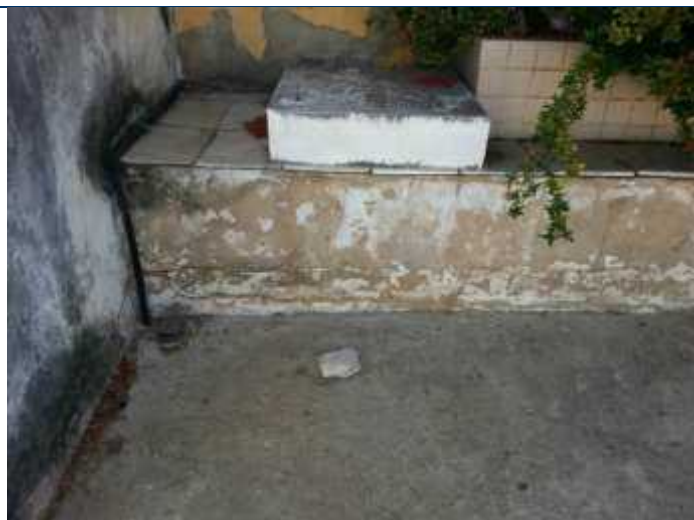
Foto 25 – Umidade na parte inferior do muro.
