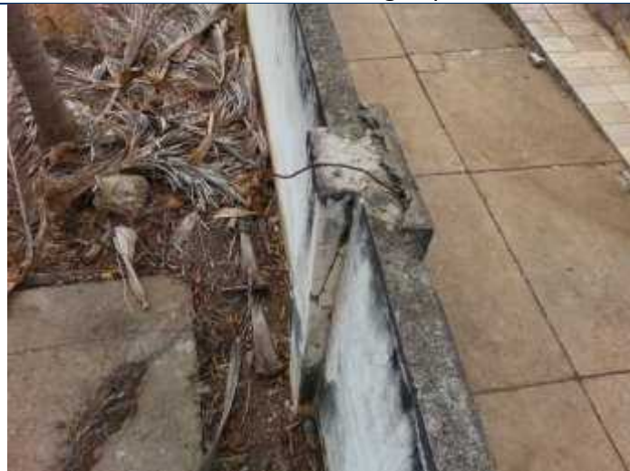
Foto 47 – Pilar recuperado de forma incorreta.
