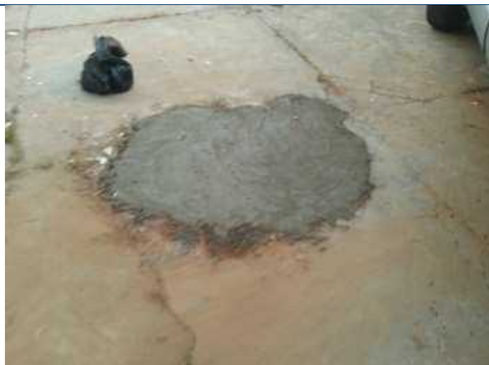
Foto 134 – Reposição do piso externo onde se inspecionou a sua espessura e aterro .
