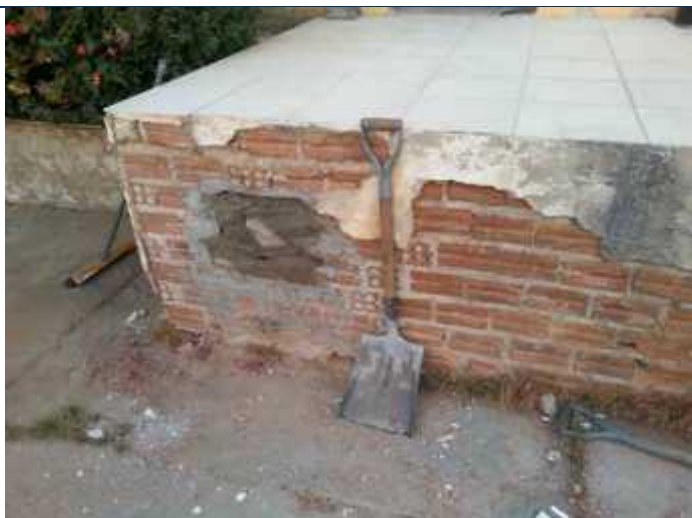
Foto 133 – Reposição da alvenaria da rampa de acessibilidade lateral.
