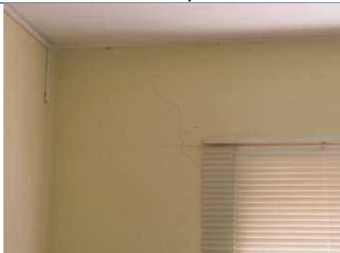
Foto 72 – Fissura 45 graus de canto acima da janela.
