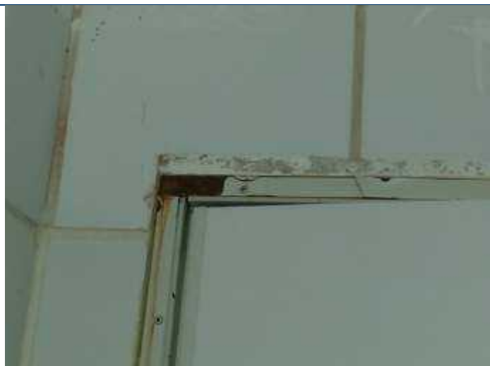
Foto 109 – Detalhe da porta do banheiro com a grade de aço oxidada.
