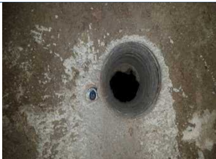
Foto 63 – Local da extração do testemunho.
