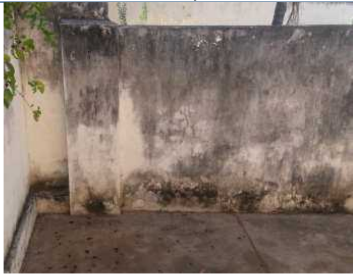
Foto 36 – Muro com manchas e fissuras
