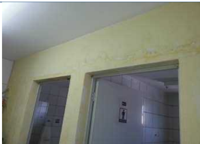
Foto 85 – Parede com manchas de infiltração.
