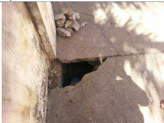
Foto 41 – Abatimento no aterro abaixo das placas de concreto.
