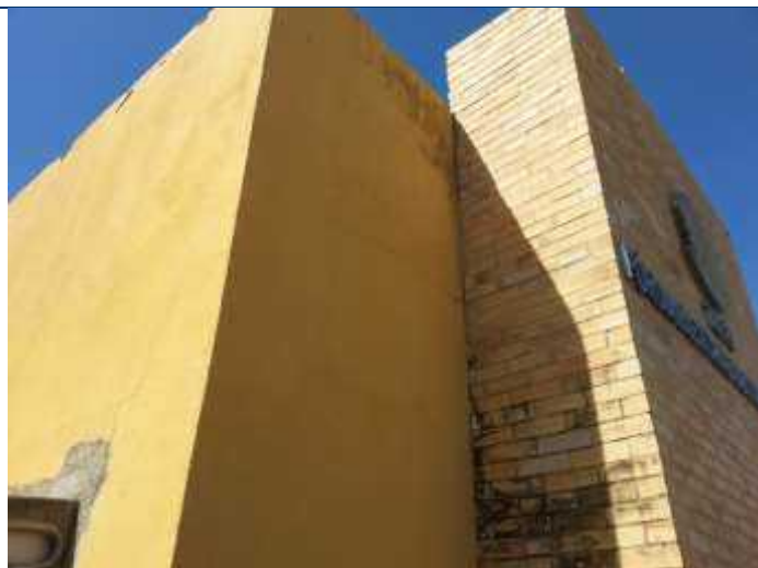
Foto 11 – Fachada fissura na alvenaria.
