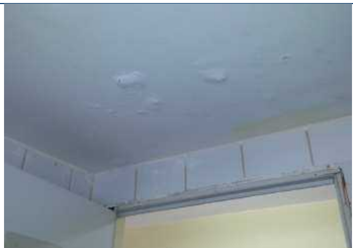
Foto 108 – Forro de gesso com umidade por conta do vazamento da caixa d'água superior.
