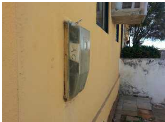
Foto 20 – Medidor de energia com abertura que permite a passagem de água de chuva.
