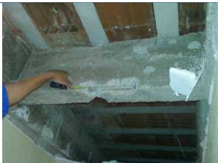
Foto 113 – Identificação da ferragem da estrutura.
