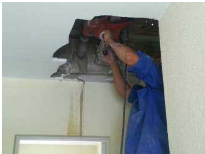
Foto 65 – Extração de corpos de prova na viga.
