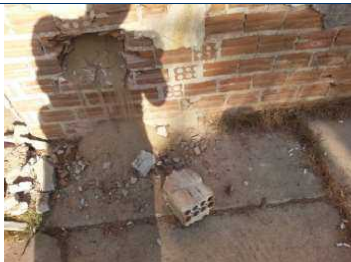
Foto 53 – Local onde foi extraído o tijolo para ser ensaiado em laboratório.
