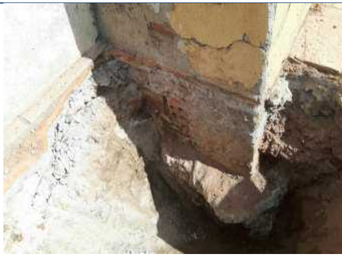
Foto 18 – Vistoria da fundação existente.
