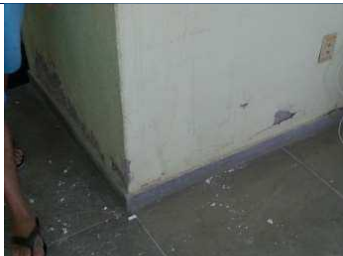
Foto 82 – Parede com reboco e pintura danificados.
