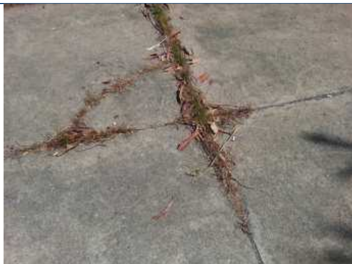
Foto 44 – Fissuras no piso externo
