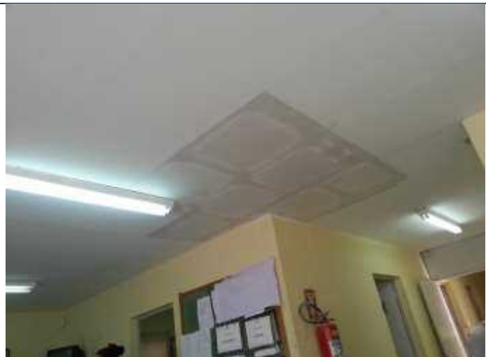
Foto 120 – Detalhe do forro de gesso recuperado.
