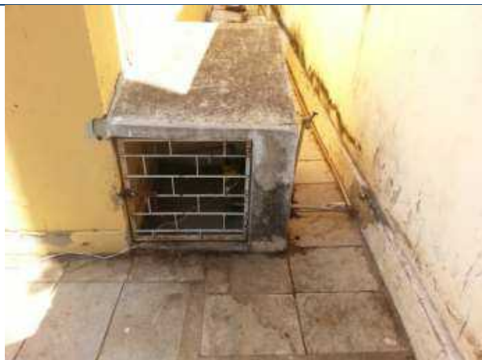
Foto 32 – Tubulação lateral que capta a água da rua.
