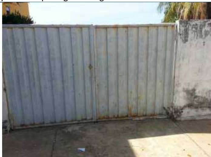
Foto 22 – Portão com vários pontos de oxidação.
