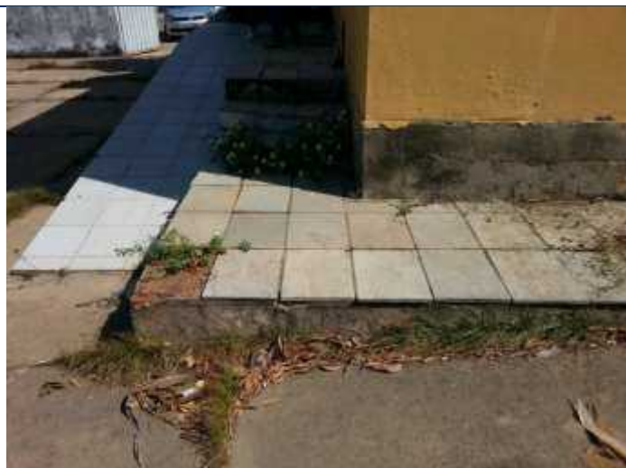
Foto 28 – Passeio com as pedras danificadas e se soltando.
