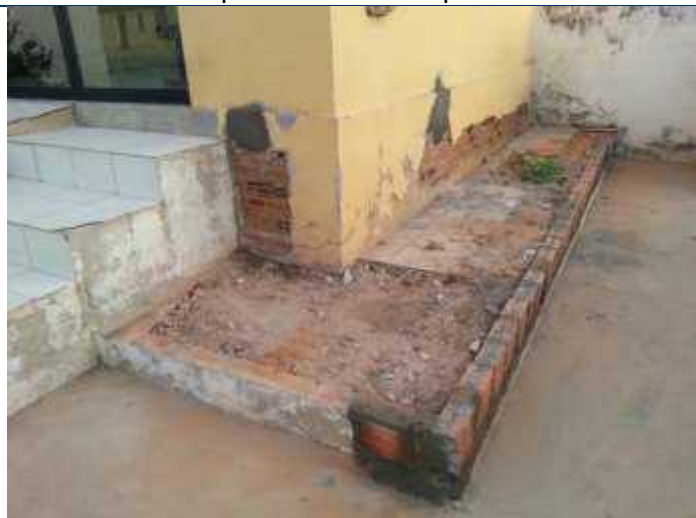
Foto 132 – Reposição do reboco e do passeio na fachada lateral direita que foram quebrados para inspeção.
