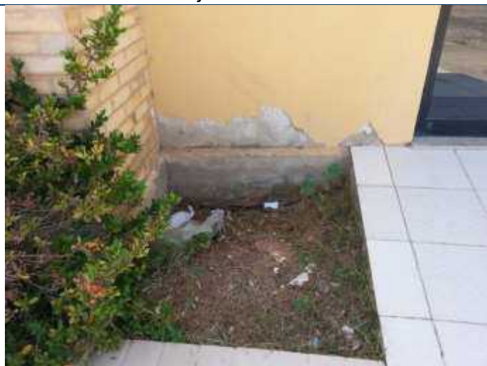
Foto 12 – Pintura danificada na fachada frontal.
