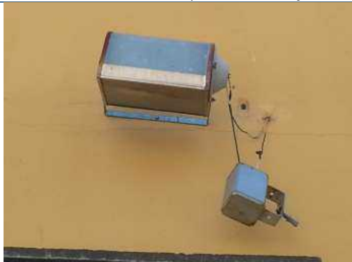
Foto 24 – Instalação elétrica de iluminação danificada.
