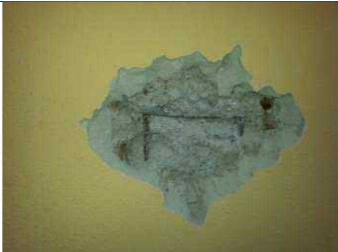
Foto 57 – Escarificação para identificação do pilar em concreto.
