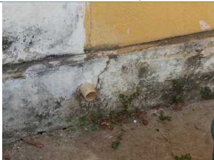
Foto 09 – Fissura vertical na fachada frontal.
