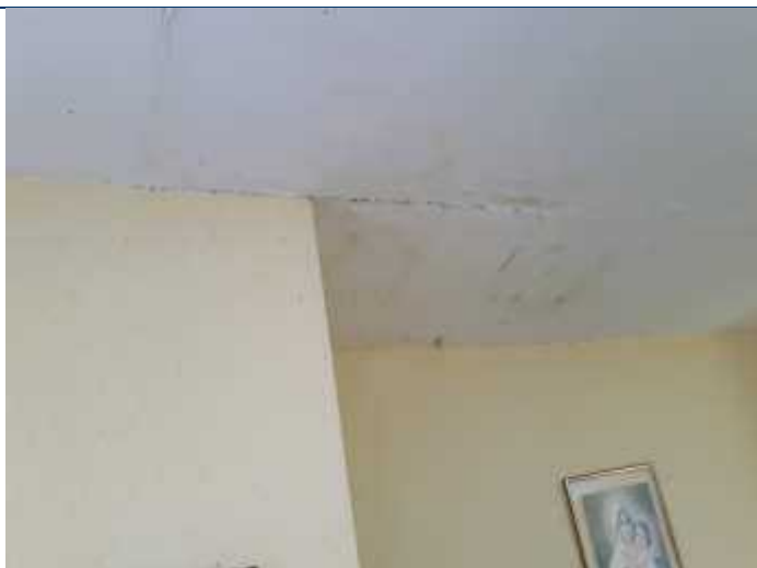
Foto 93 – Forro de gesso danificado por vazamento de água de chuva pela calha.
