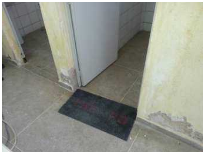
Foto 83 – Parede com manchas de infiltração e reboco danificado na sua parte inferior.
