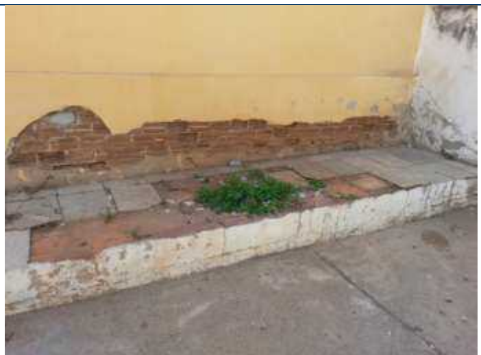
Foto 21 – Alvenaria e o passeio danificado.
