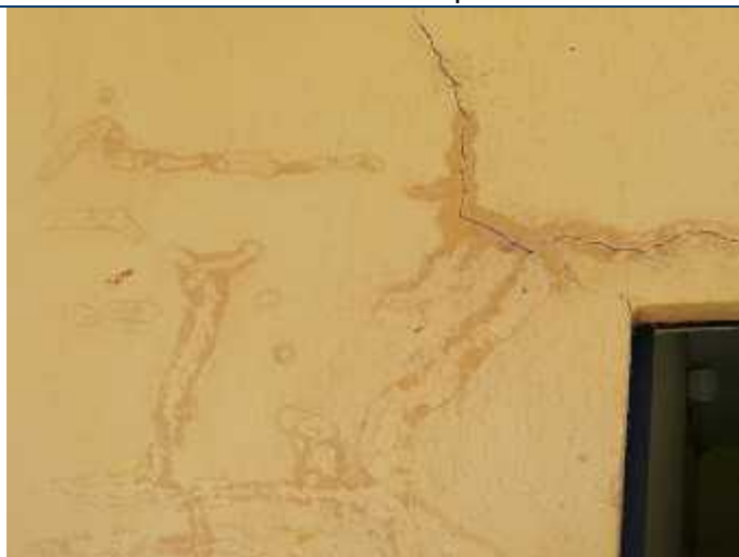
Foto 52 – Alvenaria com infiltração na entrada lateral do fórum.
