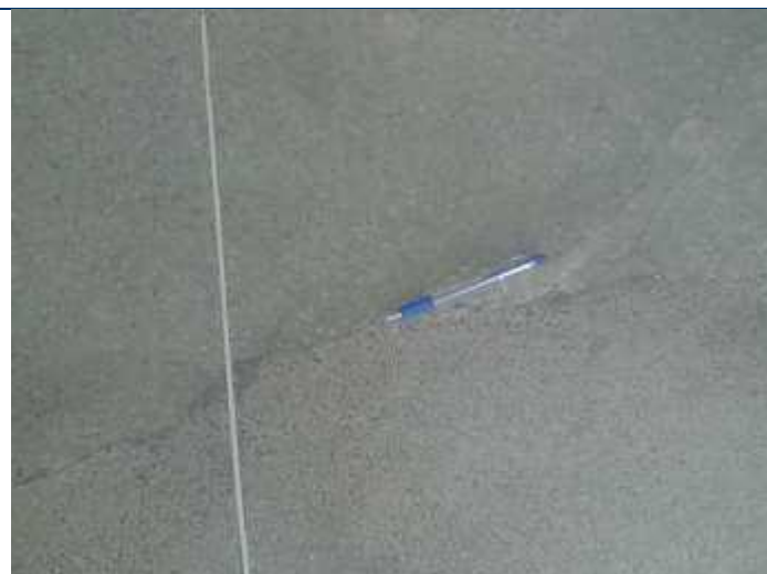
Foto 50 – Detalhe da fissura do piso.
