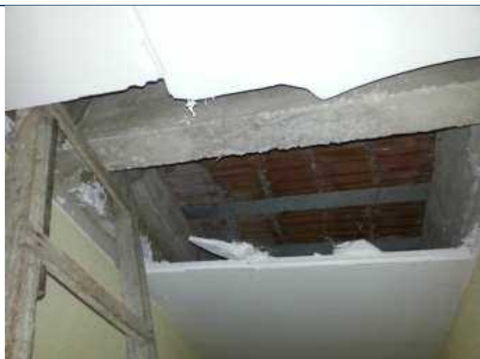
Foto 61 – Quebra do forro de gesso para inspeção na estrutura.
