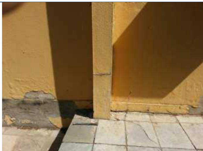
Foto 29 – Parte inferior da fachada do fundo com reboco e pintura se destacando.
