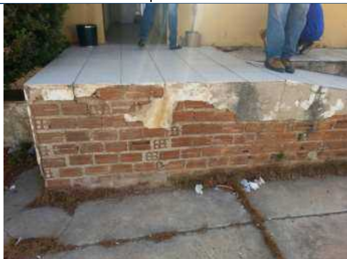
Foto 27 – Rampa de acessibilidade sem o reboco e sem corrimãos.
