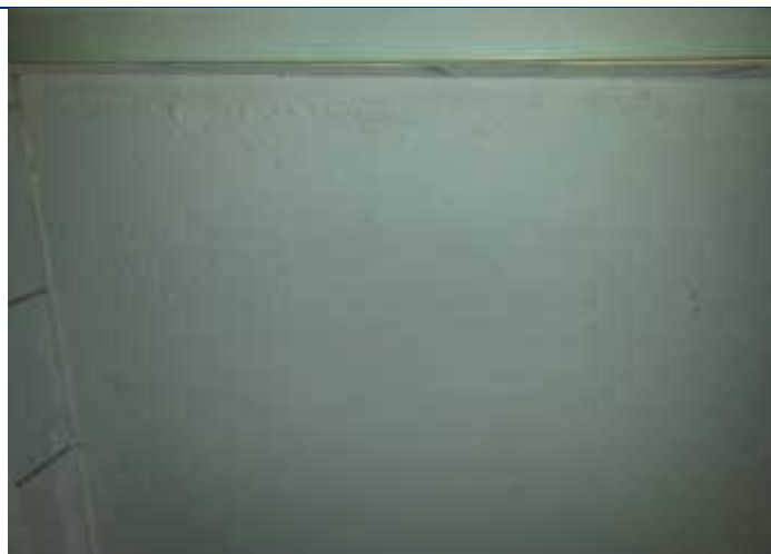
Foto 86 – Forro de gesso com manchas de infiltração no teto do banheiro.
