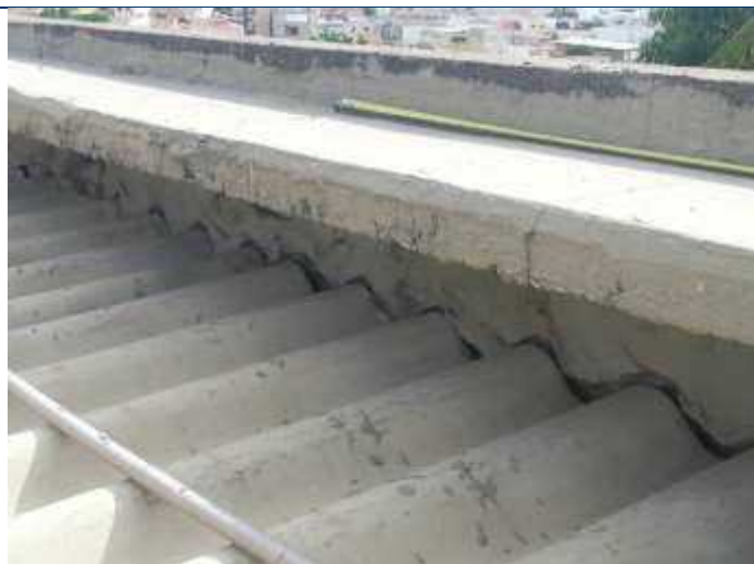
Foto 125 – Detalhe das telhas soltas abaixo do algeroz.
