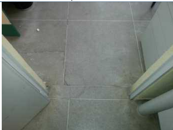
Foto 78 – Piso com várias fissuras.
