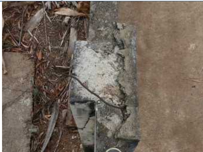
Foto 48 – Detalhe da ferragem aparente.
