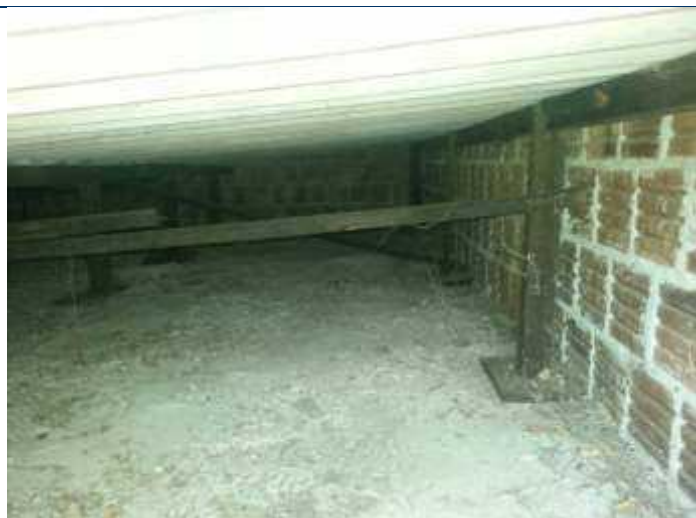
Foto 127 – Madeiramento danificado.
