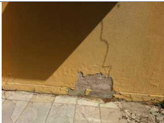
Foto 30 – Parte inferior da fachada do fundo com reboco e pintura se destacando.
