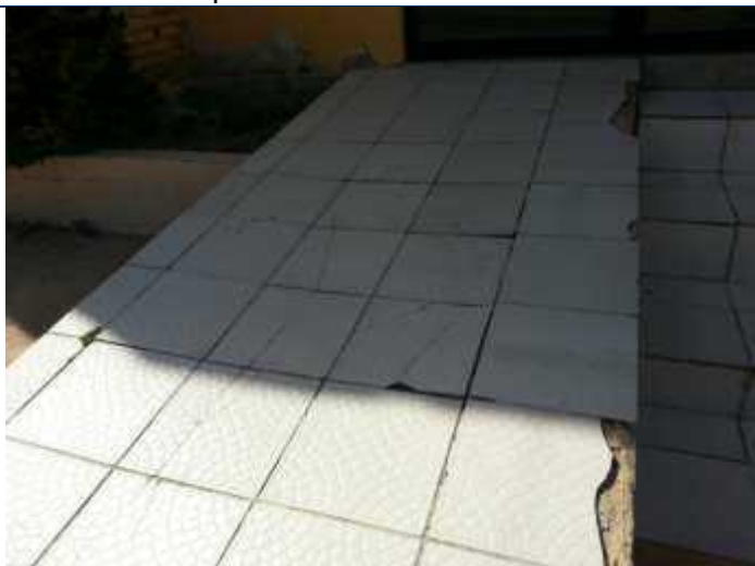
Foto 15 – Rampa de acessibilidade com abatimento do piso que está danificado.
