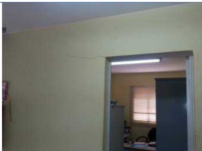
Foto 67 – Fissura inclinada de canto na parte superior esquerda da alvenaria da porta da sala.
