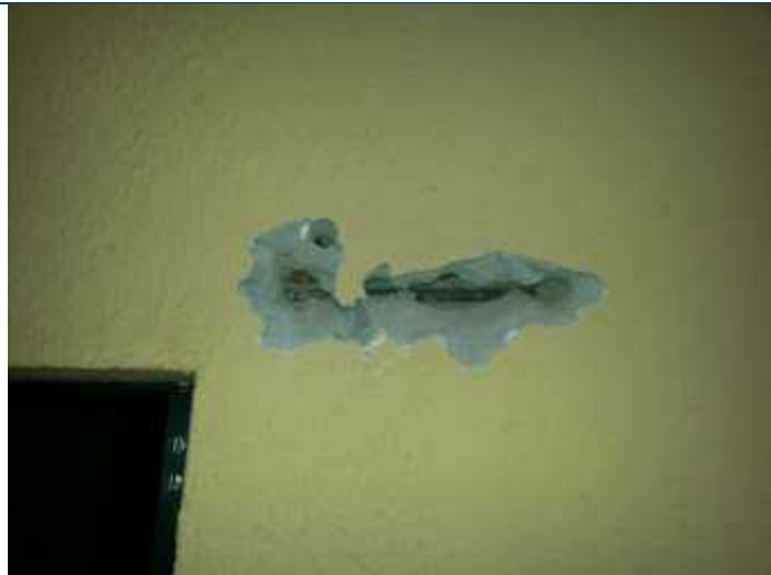
Foto 58 – Escarificação para identificação da verga.
