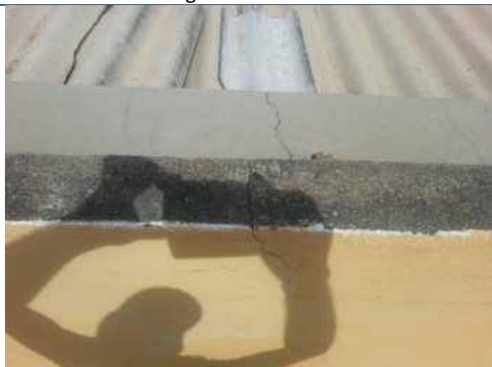
Foto 123 – Fissura na platibanda.
