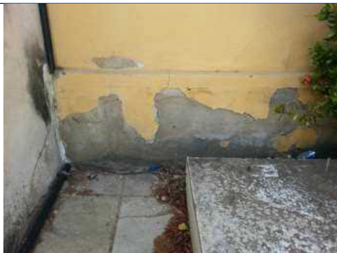
Foto 26 – Reboco danificado na fachada direita.
