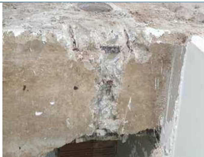
Foto 08 – Verificação da armadura da viga do fórum.
