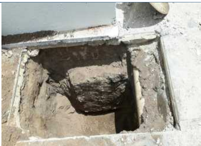
Foto 31 – Localização dos blocos de fundação.
