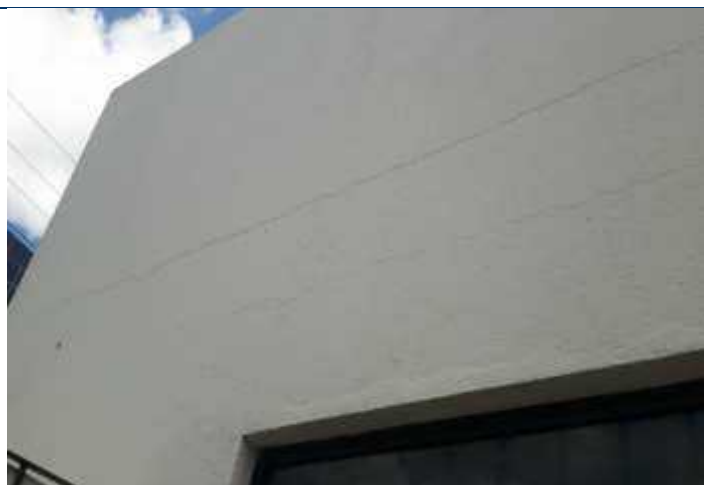
Foto 37 – Fissuras na cinta de amarração.
