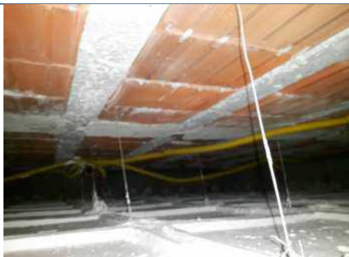
Foto 49 – Inspeção da laje pré-moldada.
