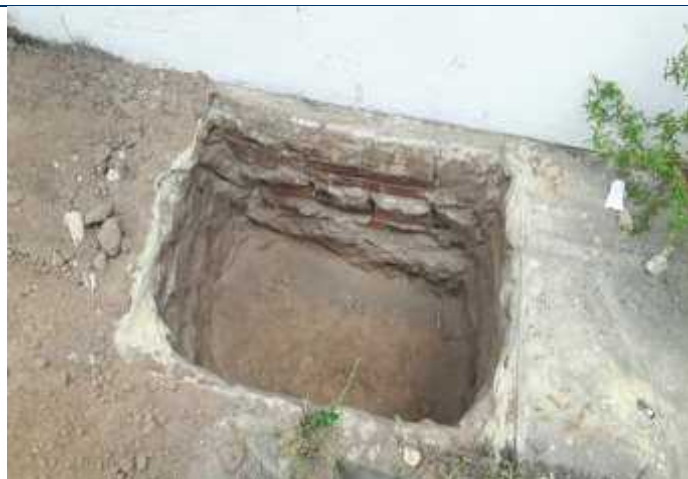
Foto 27 – Verificação dos materiais da fundação.
