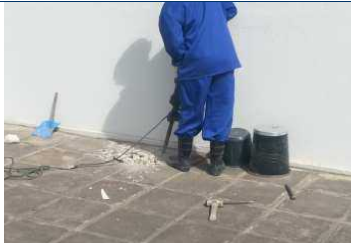
Foto 11 – Remoção das lajotas para inspeção da fundação.
