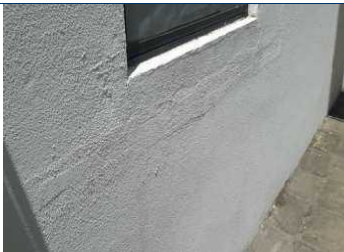
Foto 43 – Recuperação de fissuras e inclusão de contraverga.
