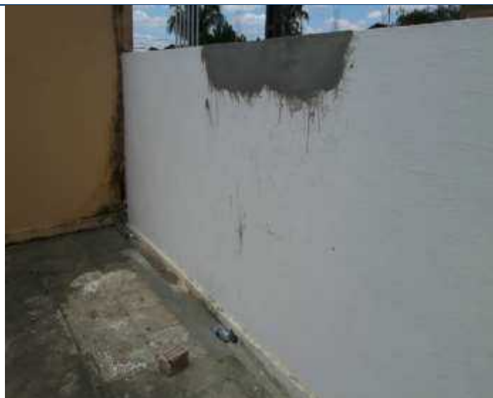
Foto 20 – Reposição da alvenaria do muro.
