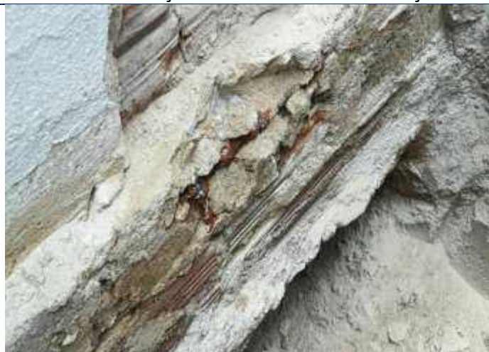
Foto 29 – Presença de oxidação na armadura do radier da edificação.
