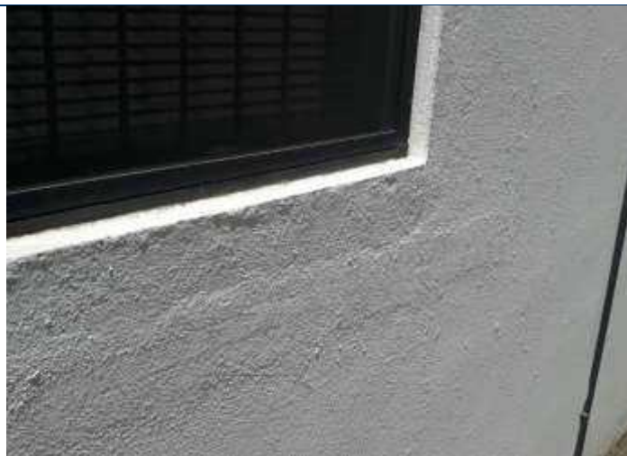
Foto 42 – Recuperação de fissuras e inclusão de contra-verga.
