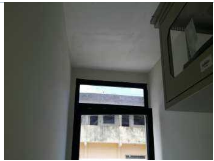
Foto 18 – Reposição do forro de gesso.
