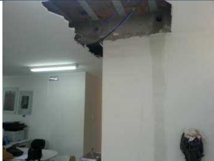
Foto 10 – Remoção do gesso para inspeção da laje.
