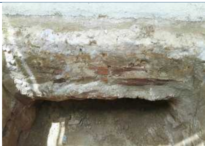
Foto 25 – Verificação dos materiais da fundação em rachão e areia.
