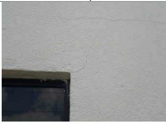
Foto 36 – Fissuras na cinta de amarração.
