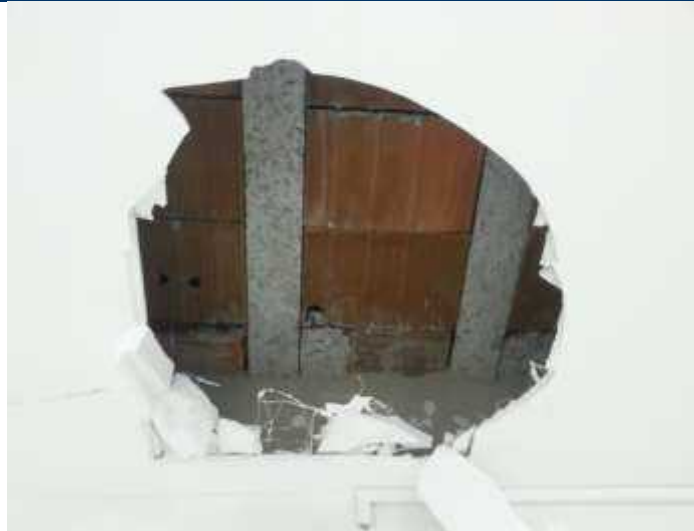
Foto 09 – Remoção do gesso para inspeção da laje.
