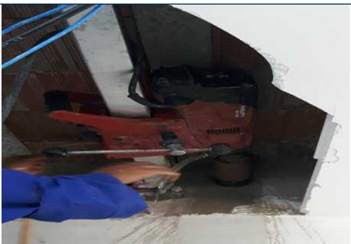
Foto 15 – Perfuratriz diamantada, marca Hilti, modelo DD 160 .
