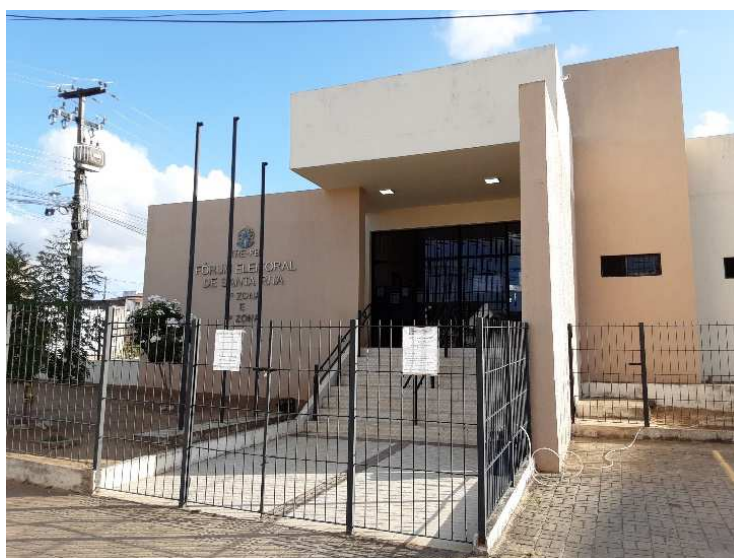
Figura 6 – Prédio do Fórum Eleitoral de Santa Rita/PB Fonte: Autor (2021)
