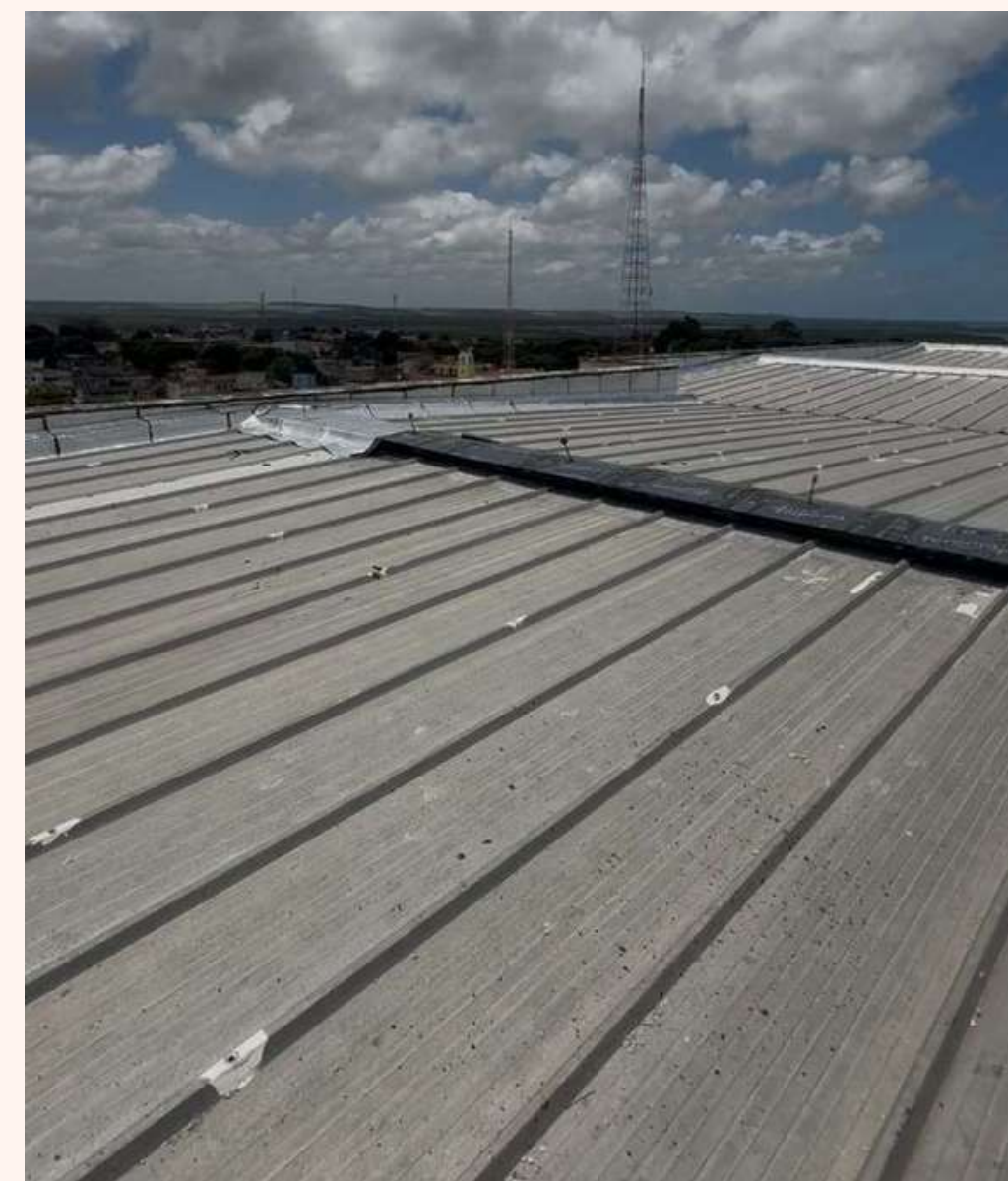
Telhado do TRE/PB
